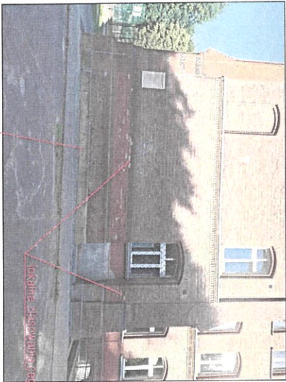
uszkodzenia powierzchni elementów kamiennych cokołu - złuszczenia i rozwarstwienia
